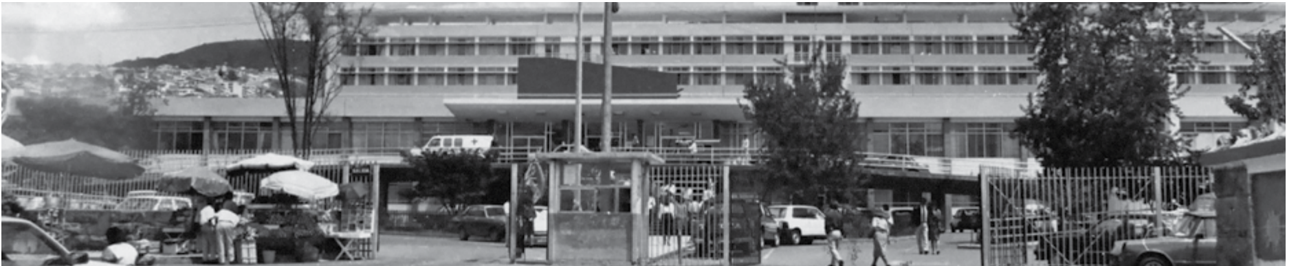
Fachada externa del Hopistal de Especialidades Carlos Andrade Marín, calle Ayacucho.
