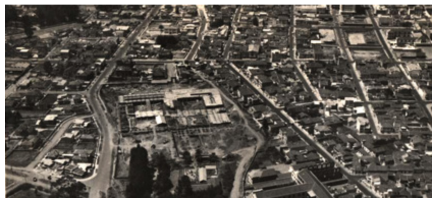
Vista aérea de la edificación del HCAM.
