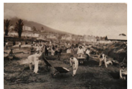
Inició la nivelación de tierras y construcción del Hospital de la Caja del Seguro con 704 obreros, sobre una superficie de 41.829,24 m 2 .
